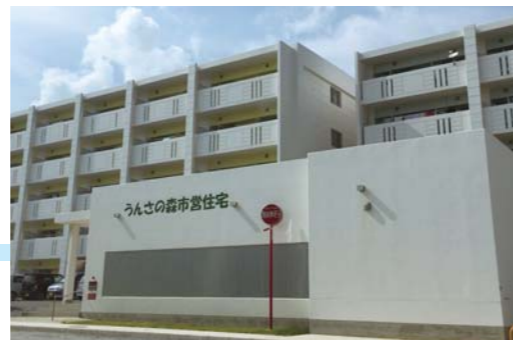
建て替え後の「うむさの森市営住宅」。
